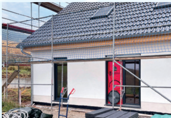
BlowerDoor Messung in einem Neubau
