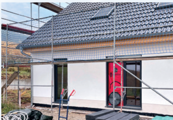
BlowerDoor Messung in einem Neubau
